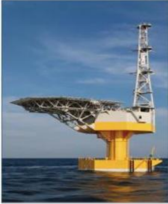
図 17. 洋上変電所設備(福島実証事業) 55
